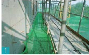
1 강관비계 설치 사례
